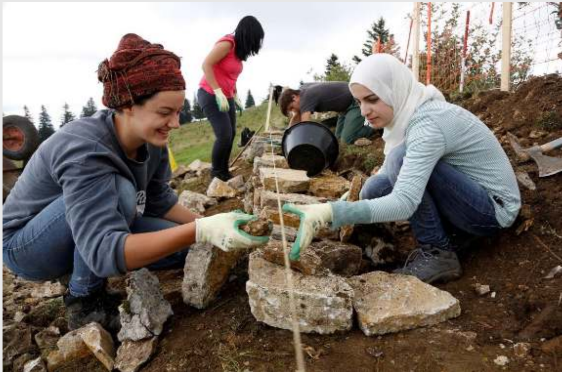
MUR DE PIERRE SÈCHES « Building Walls - Breaking Walls »
